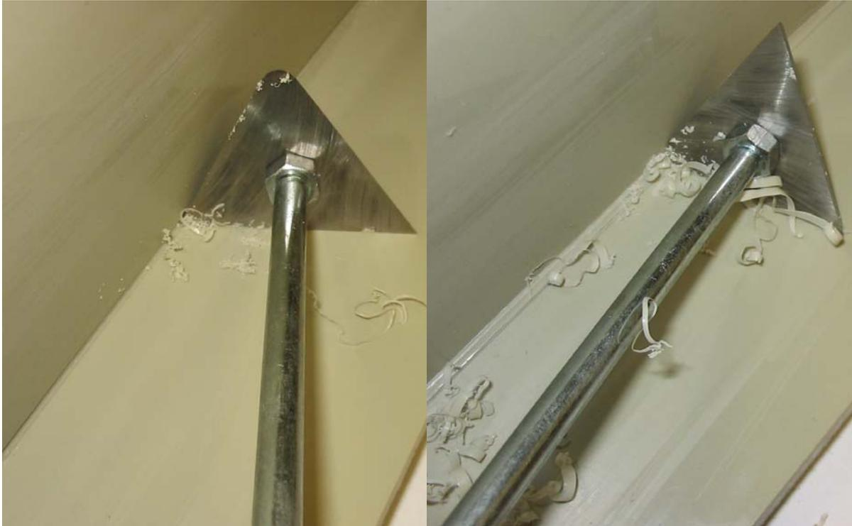
**Рис.10 Зачистка поверхностей перед сваркой шва К-типа**
