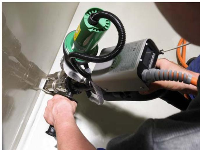
Рис.1 Выполнение сварного шва К-типа
